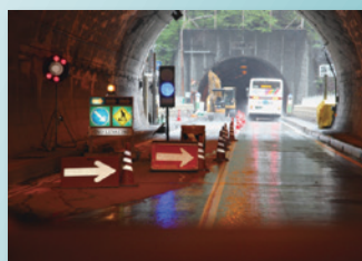
共同溝、洞道、工事現場
